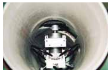
取付管接合部の穿孔を行う作業用ICPロボット。
