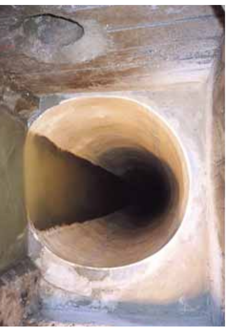
複合管施工後。
