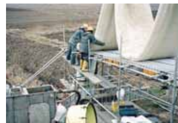
大口径本管ライニング施工中。
