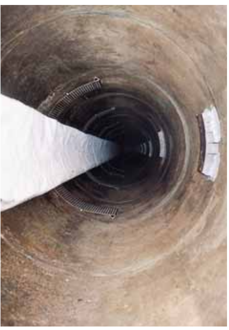
ICPスーサーおよびスターライナー設置。
