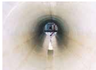
ICPブリース工法で施工後。
