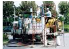
省スペースでの施工が可能。
