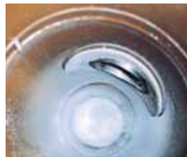
取付管口を守るSカラー。
