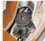
取付管口を保護するSカラー。
