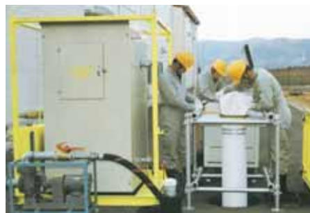
本管ライニング施工中。
