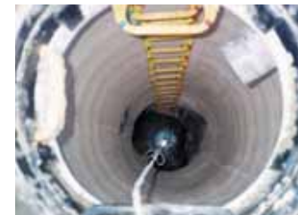
ICPブリース工法マンホールライニング施工後。
